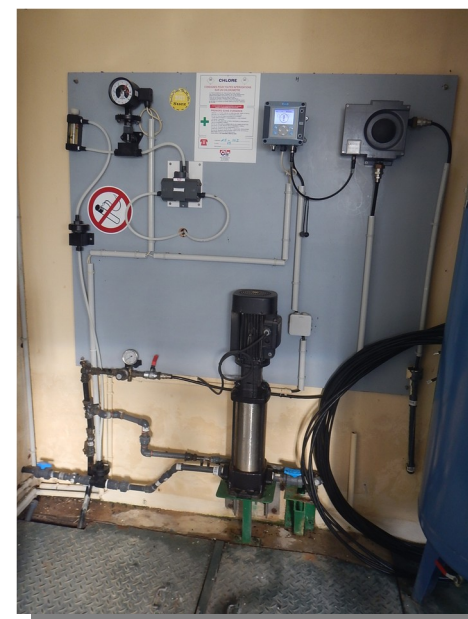
Système de chloration
